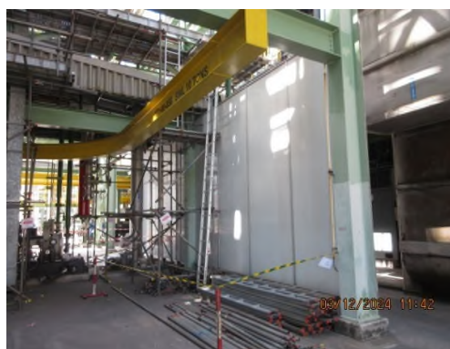
ภาพถ่ายที่ 2.2.2-23 บริเวณที่มีการติดตั้งอุปกรณ์ เพื่อลดความดังเสียงและป้องกันเสียง
